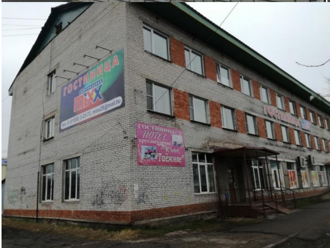
Фотоотчет, проверки 26.04.2018г. по избавлению от «визуального мусора» и созданию привлекательного облика МО «Жоношское»
