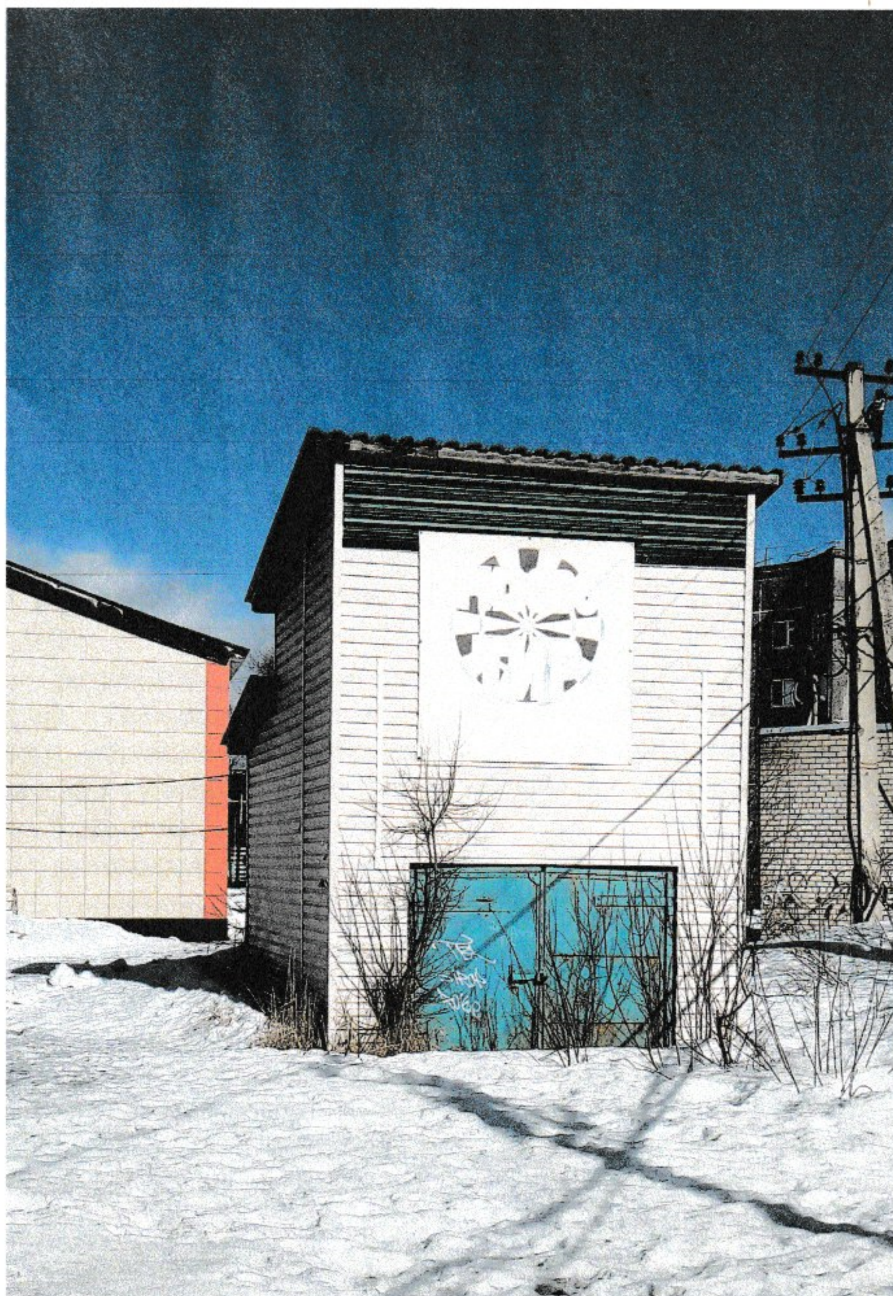
Фотоотчет проверки 02.04.2021 по избавлению от «визуального мусора» и созданию привлекательного облика по адресу: п.Коноша, ул. Советская, д.86, сооружение 2
